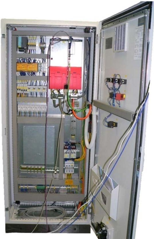
Abbildung 3 - Schaltschrank mit Antriebsregler
